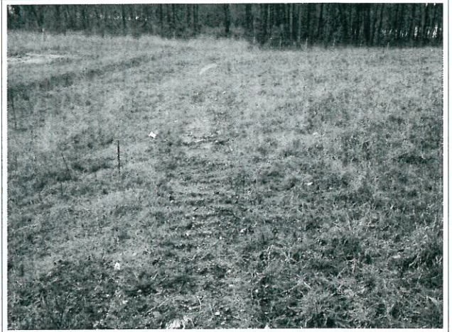
Photo n° 10 : Drain périphérique et couverture herbacée
