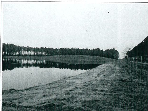
Photo n° 1 : Clôture et pentes supérieures à 3 %
