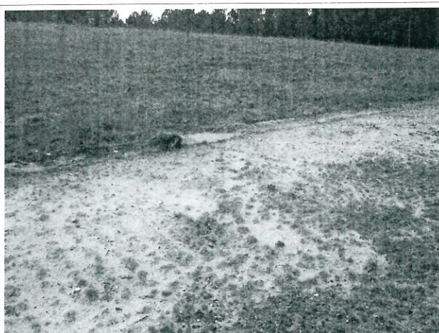
Photo n° 11 : Drain périphérique et couverture herbacée
